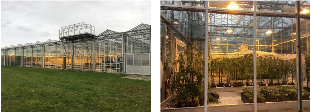
図 3 : WUR の試験ハウスの外観および内部
